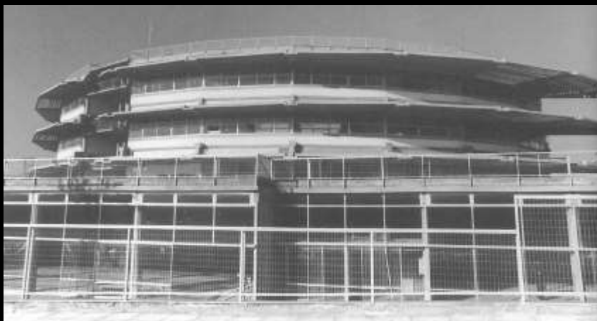
Γενική άποψη αμέσως μετά την ολοκλήρωση της κατασκευής.
