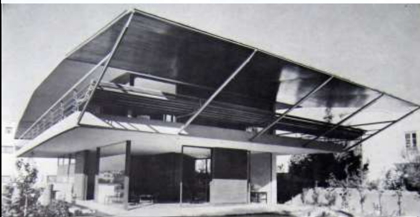
Κατοικία, Σάνθου 21, Γλυφάδα, 1961 (Βλ. και 'Υδροτεχνική' 62/1967)
